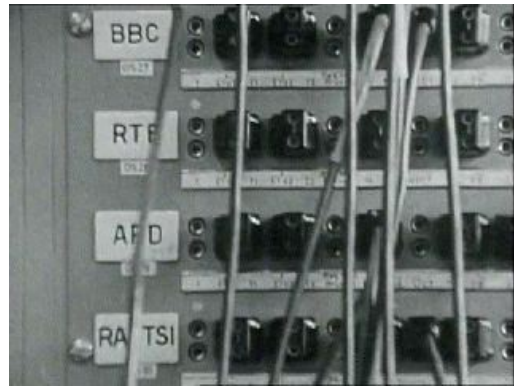
FIGURE 23 – Console qui distribue le signal entre les télévisions, J.O. d'hiver 1964.
