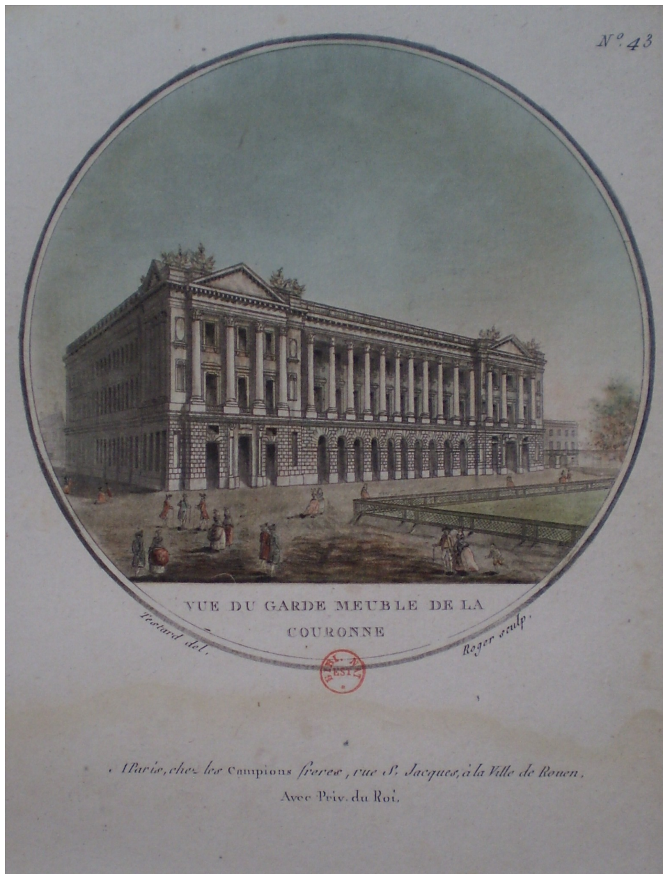
Vue du Garde-Meuble de la Couronne , tirée des Vues pittoresques des principaux édifices de Paris , Paris, Campions frères et fils, entre 1787 et 1789, Bibliothèque nationale de France [VE-349-4]. Voir première partie, chapitre 1.
