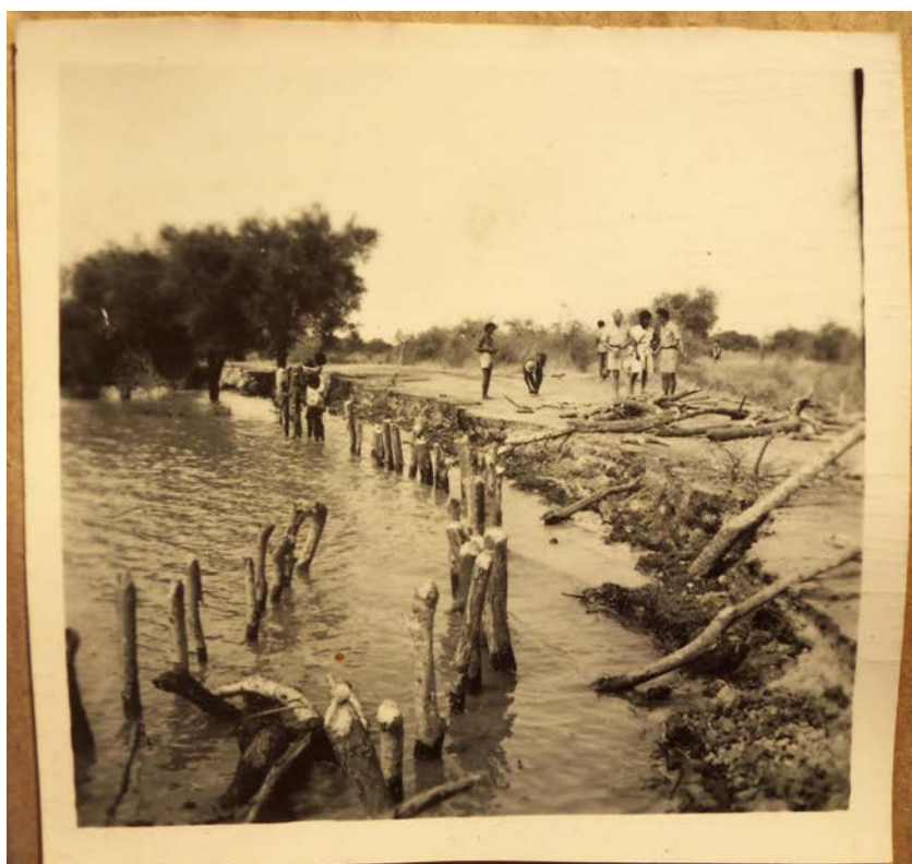
Figure 13 : Km. 14. Réfection de la piste [autour de Rosso, fin 1950], SG MS-5570
