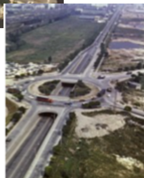
Médiathèque Terra MTES
