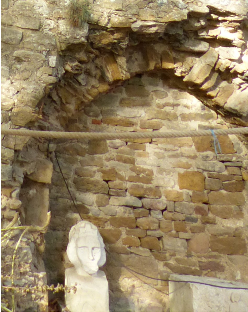
34. Courtine nord, niche, détail
